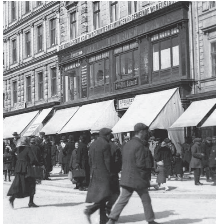
Das Büro der Stadtwerke gegenüber dem Rathaus am Hauptplatz 31.
